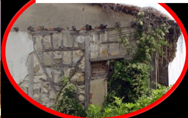
Σχήμα 1.1 Παραμόρφωση κτιρίου από άοπλη τοιχοποιία, χωρίς διαφράγματα, όταν υπόκειται σε σεισμική δράση (Professor Kuldeep S. Viridi).
